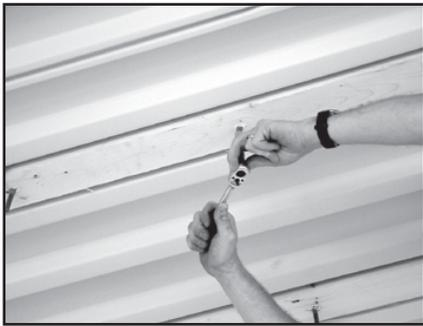
Fig. 11: Installing the hanger bolt.
