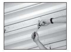
Fig. 11: Installing the hanger bolt.
